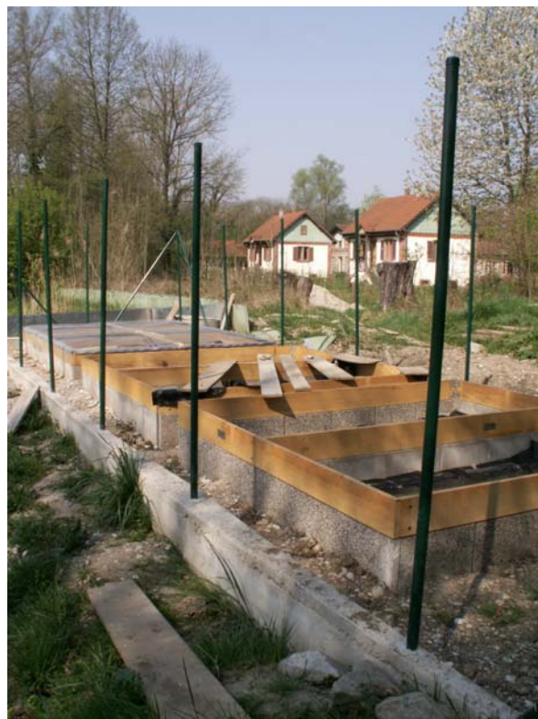
Aménagement des enclos destinés aux cistudes de 1 à 3 ans
